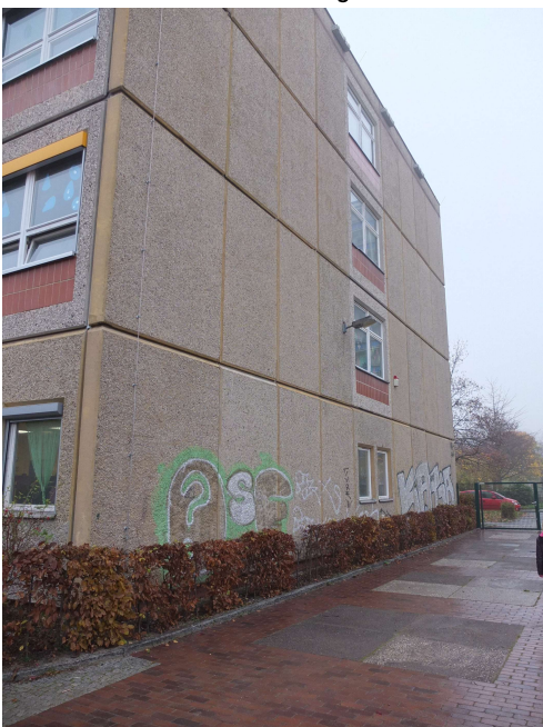
Ansicht vor der Sanierung
