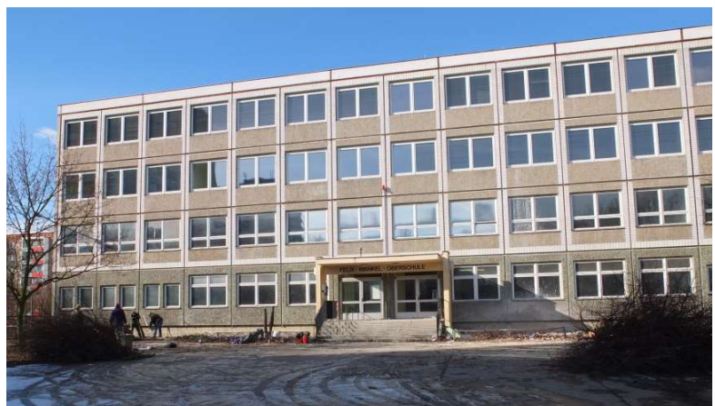
Ansicht vor der Sanierung
