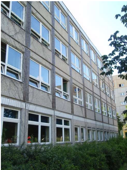
Ansicht vor der Sanierung
